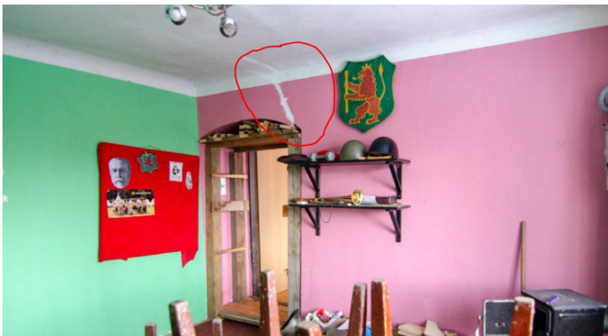
Obr. Trhliny v nosných stěnách objektu
